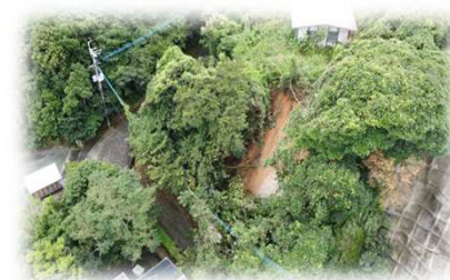
<がけ崩れの状況>
